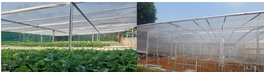
Gambar 1. Fasilitas Yang Sudah Diperbaiki
