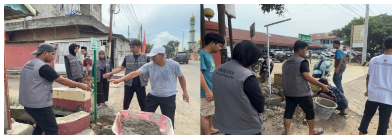
Gambar 1. Proses pemasangan plang jalan
