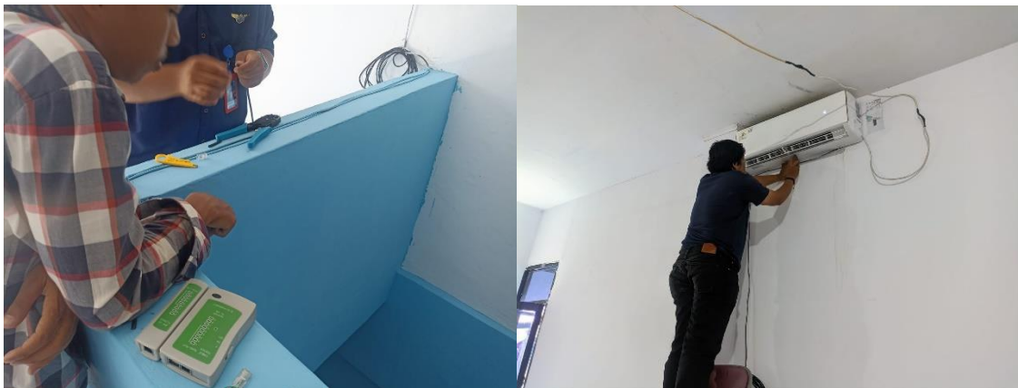
Gambar 2. Perakitan dan Instalasi Kabel LAN
