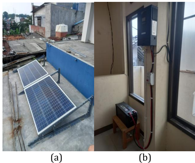
Gambar 3. Pemasangan Panel Surya, Inverter dan Baterai
