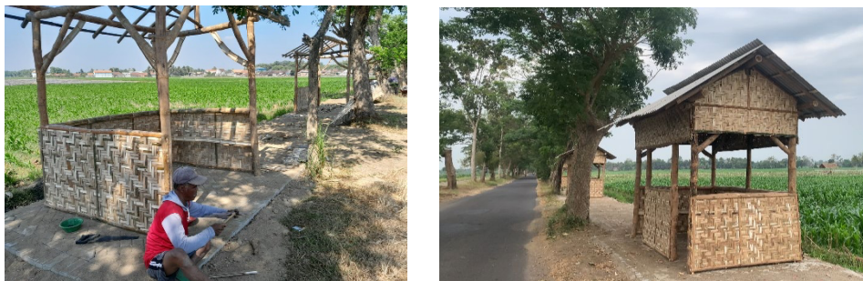
Gambar 9. Hasil Pembangunan Gazebo dan Paving
