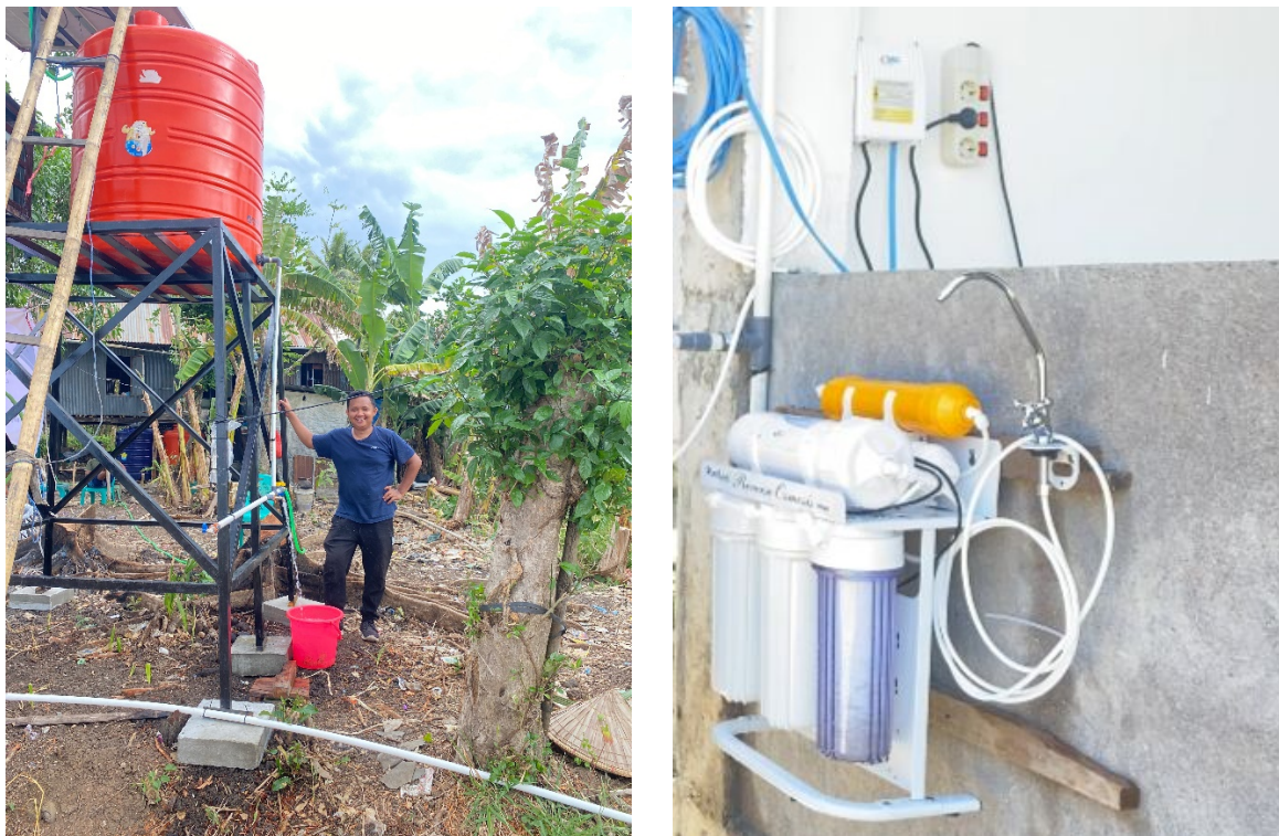
Gambar 5. (a) Pemasangan panel surya, batu zeolit, kain penyaring, karbon aktif, silika, (b) pemasangan mesin reverse osmosis
