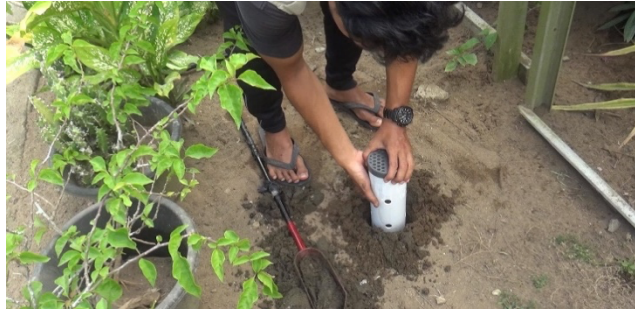
Gambar 5. Proses pemasukan pipa kedalam lubang
