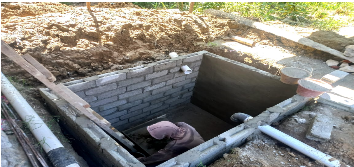
Gambar 3. Proses Pembuatan Septik Tank Untuk Jamban Sehat
